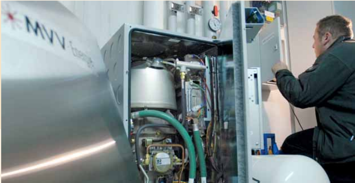
Die stromerzeugende Heizung namens „WhisperGen“ besteht aus einem Stirlingmotor samt Wärmetauscher. Diese Komponenten werden in die Wärme- und Stromversorgung eines Hauses integriert und mit modernster Technik fernüberwacht.
