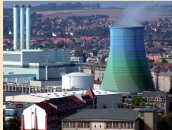
Modernes KWK-Kraftwerk der DREWAG.
