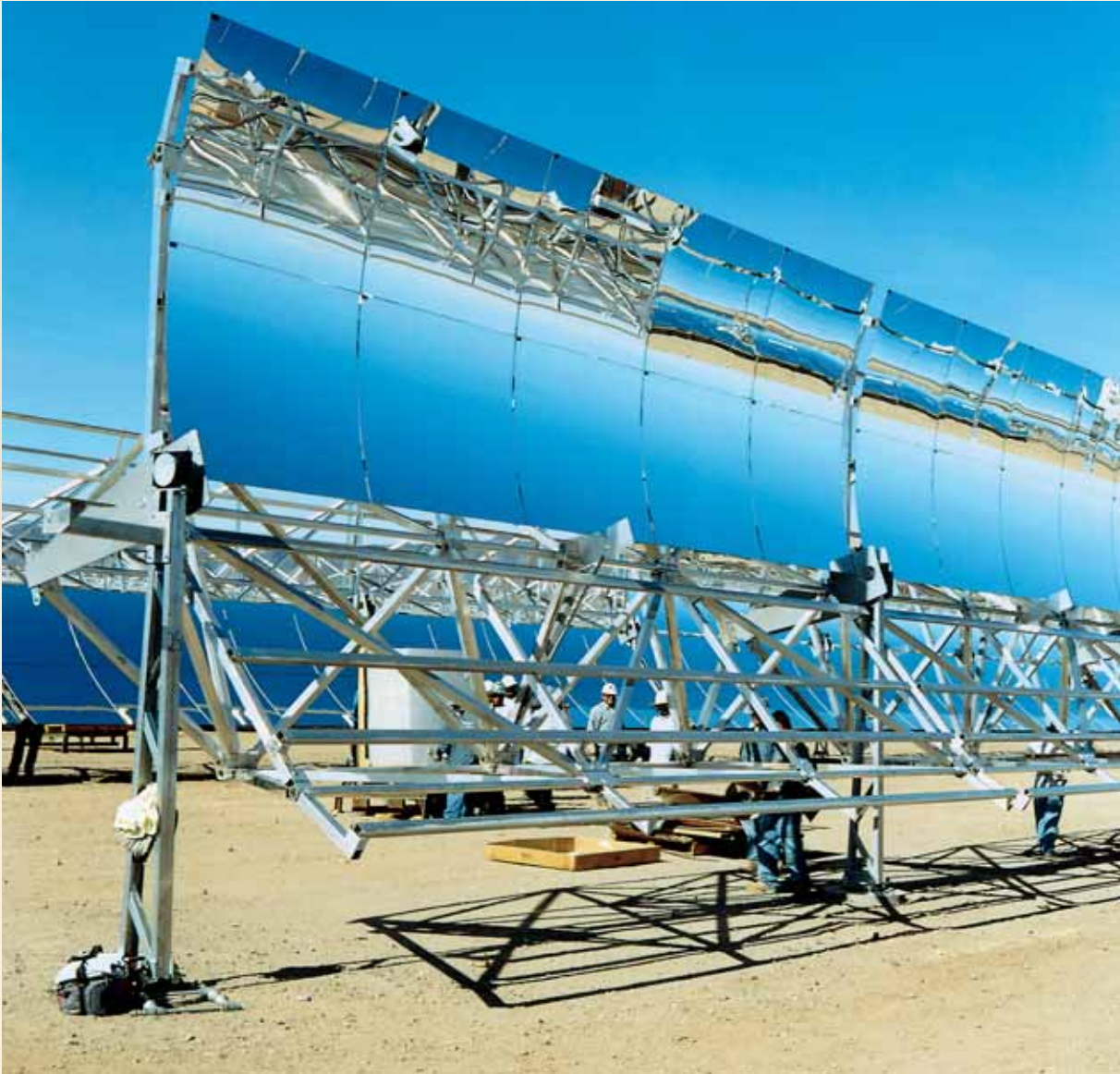
Solare Rinnenkraftwerke für ergiebige Sonnenschein-Regionen.
