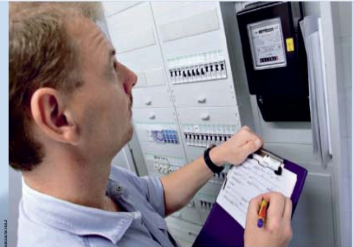
Erst durch lückenlose Information über Energieerbräuche lassen sich alle Sparpotenziale aufdecken und realisieren
